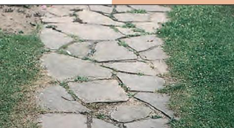
Mosaikartig verlegte Gehwegplatten mit breiten Fugen lassen der Vegetation breiten Raum. Grünanteil bis zu 25%, (Versickerungsleistung 20 bis 40%). Geeignet für Gehwege und Terrassen.
