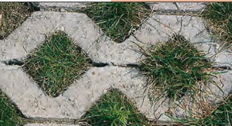
Rasengittersteine sind Betonsteine mit wabenförmigen Öffnungen, die mit Humus gefüllt und mit Rasen bewachsen sind (Grünanteil bis zu 45 %, Versickerungsleistung bis zu 80%). Geeignet für Stellplätze und Fahrwege.
