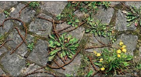
Mosaik- und Kleinpflaster besitzen bis zu zwei Zentimeter breite Fugen zwischen den Steinen, die mit Mutterboden und Sand verfüllt werden (Grünanteil bis zu 35 %, Versickerungsleistung 30 bis 50 %). Geeignet für Höfe, Stellplätze sowie Fahr- und Gehwege.
